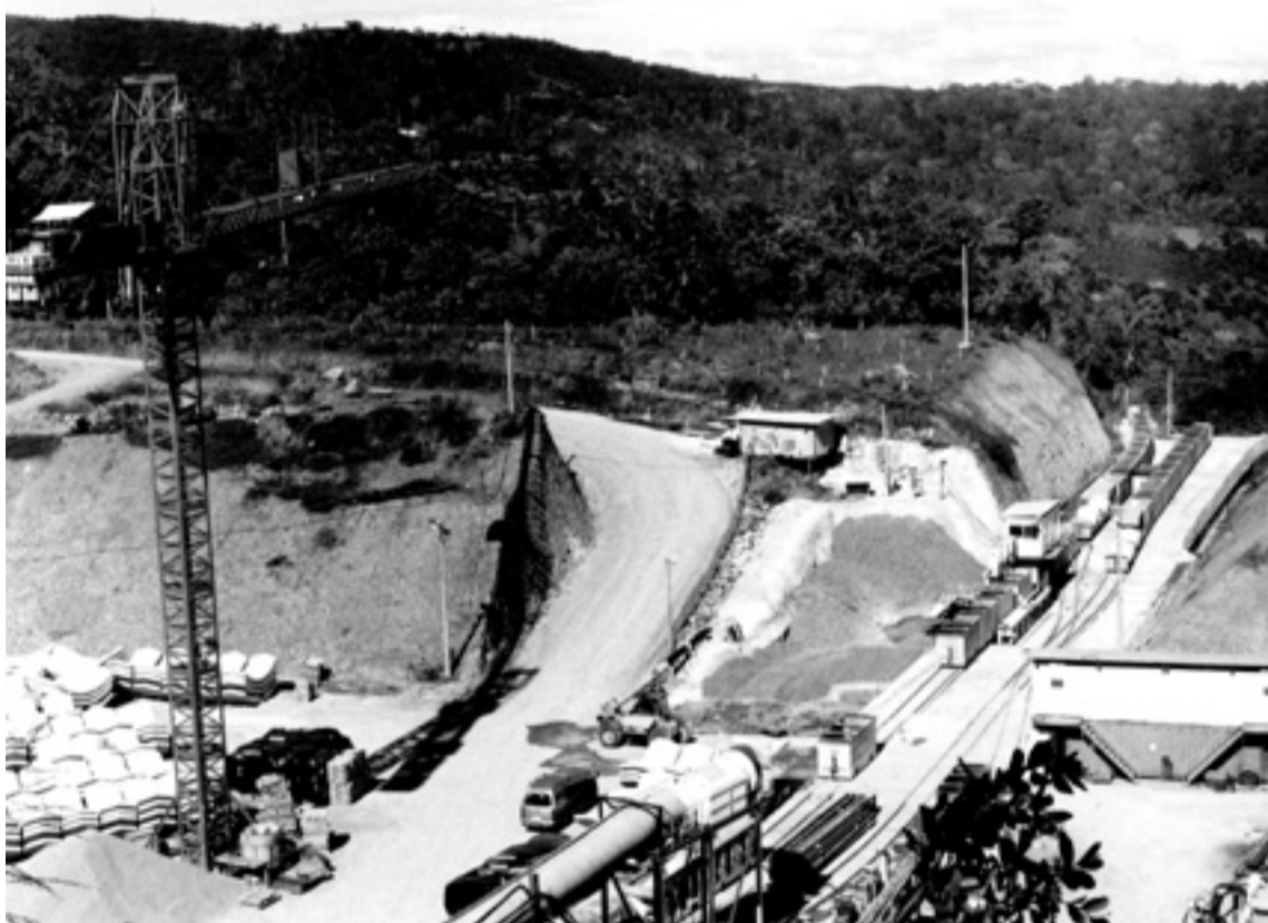
LAS OBRAS DE UNIÓN FENOSA EN COSTA RICA. Fueron paralizadas en dos ocasiones por los impactos que está ocasionando un túnel subterráneo en seis comunidades que se están quedando sin agua. En enero de 2005 Unión Fenosa reanudaba las obras.
