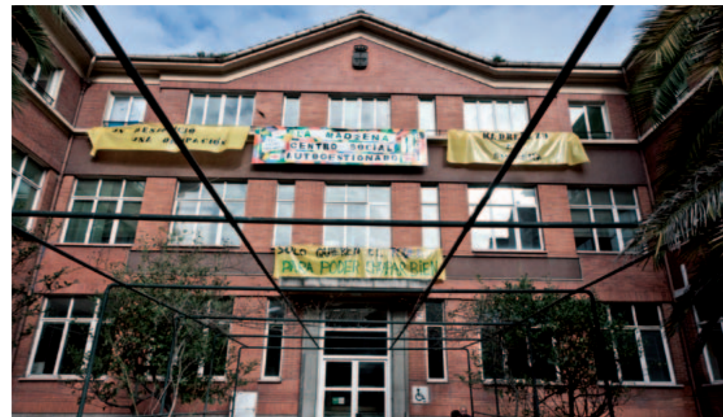
RECUPERACIÓN. El edificio que alojaba la antigua Consejería de Sanidad en la calle General Elorza de Uviéu estaba en una situación de abandono total.
